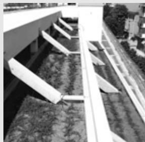
I tetti verdi sono sistemi multistrato permeabili sopra uno strato drenante che possono ricoprire con vegetazione i tetti degli edifici, piattaforme, parcheggi. Sono progettati per intercettare e trattenere l'acqua piovana, attenuando il picchi massimi di deflusso.
