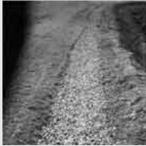
Riempite con detriti o pietre le trincee infiltranti e filtranti sono scavate in profondità nel terreno e creano superfici per stazionamenti temporanei dell'acqua piovana. Sono dispositivi con la possibilità di ricaricare le falde acquifere preservandone il loro livello.
