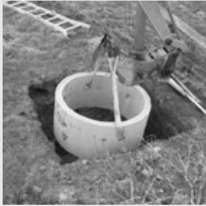
Sono cisterne sotterranee di forma quadrata o circolare che vengono alloggiare in contenitori di materiale plastico precedentemente inseriti nel terreno oppure ricoperte in terra battuta o in ghiaino. Possono essere collegate tra loro per il drenaggio di vaste aree aumentando la loro efficacia nella riduzione del rischio idraulico.
