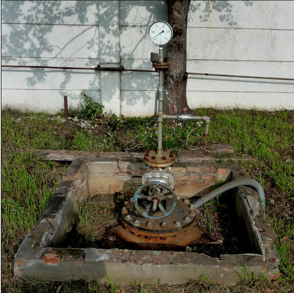
*Figura 11.4: Esempio di pozzo artesiano (livello saliente misurato dal manometro)*
