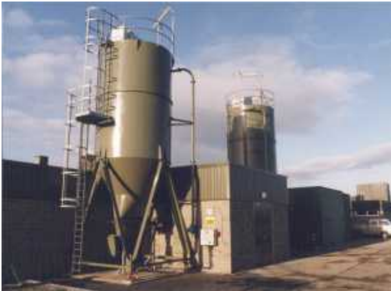
Sistema d'automatizzazione del dosaggio di PAC dai silii
