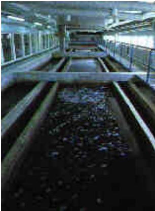
Impianti per il trattamento dell'acqua comunale
